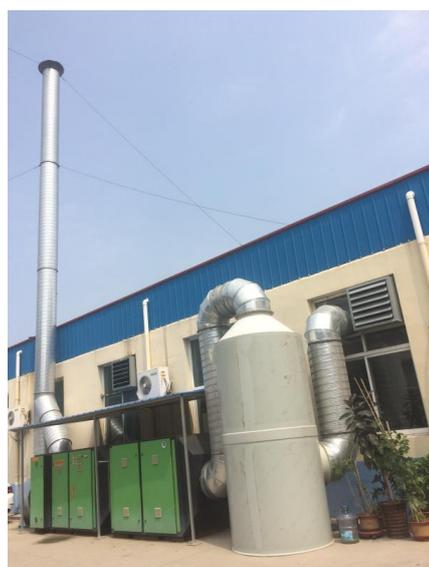
图 4-4 墨囊注塑排气筒
