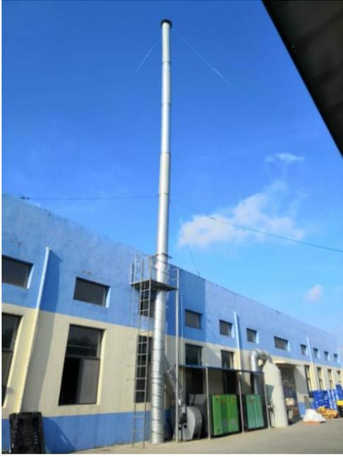
图 4-6 修正带注塑排气筒
