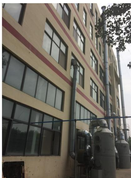
图 4-5 书写笔注塑及印刷工序排气筒
